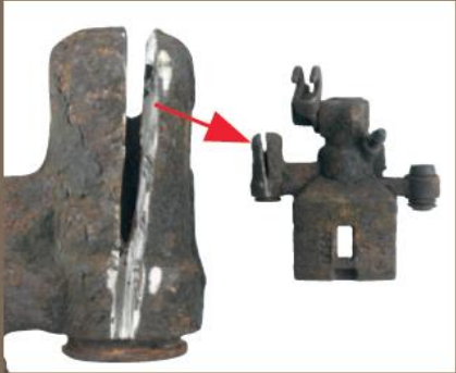
Braț suport deteriorat
